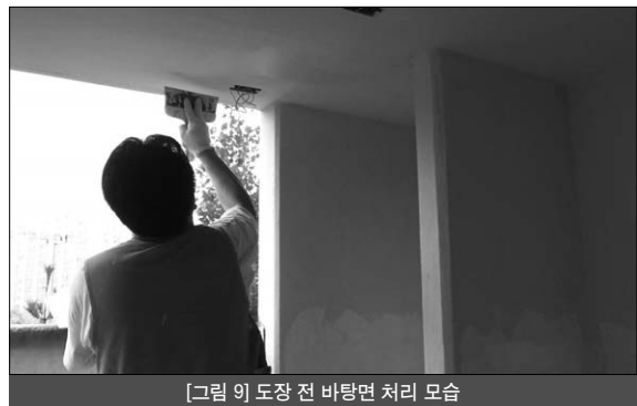
[그림 9] 도장 전 바탕면 처리 모습
