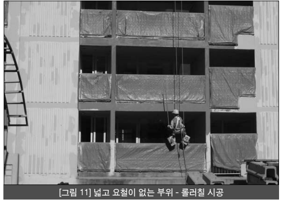
[그림 11] 넓고 요철이 없는 부위 - 롤러칠 시공
