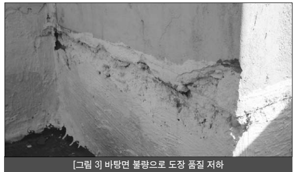
〔그림 3〕 바탕면 불량으로 도장 품질 저하
