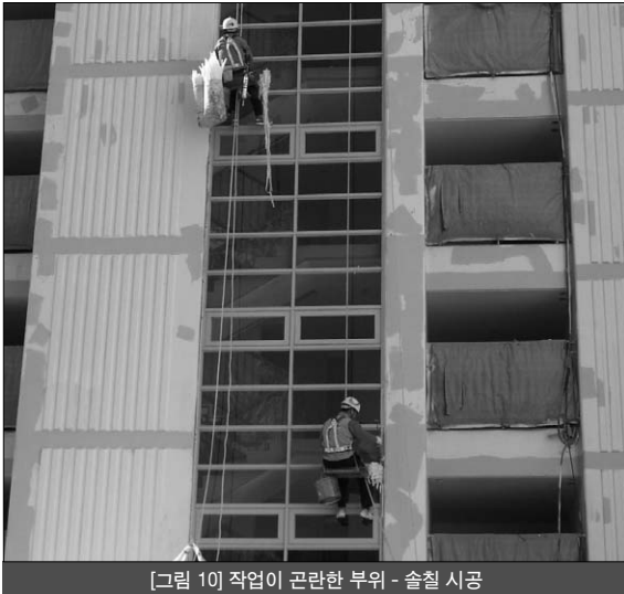
[그림 10] 작업이 곤란한 부위 - 솔칠 시공
